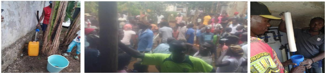
30 décembre 2022, l'EAU arrive au pied de local technique. Les essais sont fructueux. Mais le système de filtration est à installer.
